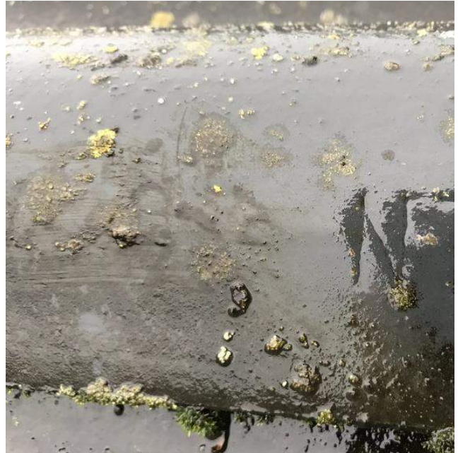
Nt codering dak schuur buiten onderzoeksgebied
