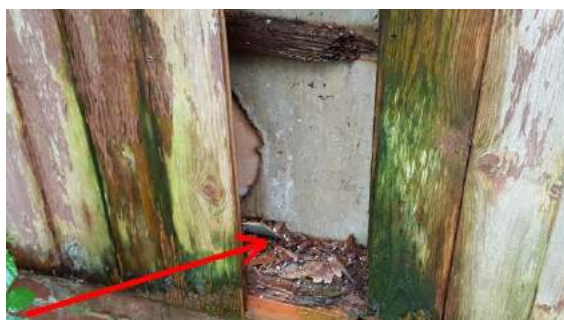
Bron 13 en MM-04 restanten in spouw linkerzijgevel
