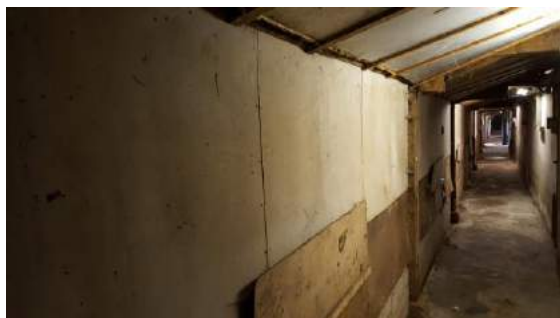
Bron 14 en MM-04 vlakke beplating binnenzijde schuur 4
