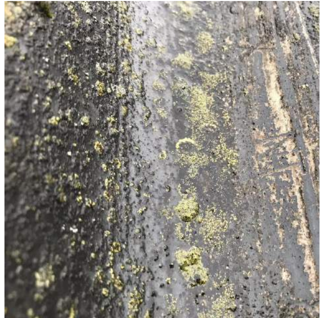
Nt codering golfplaten dak schuur 5
