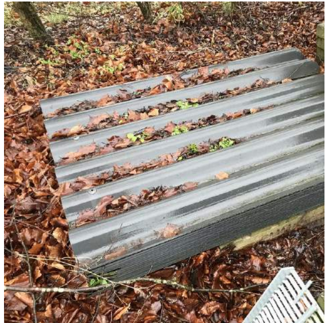
Asbestvrije golfplaten op mestplaat
