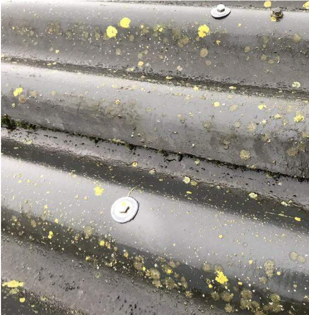
Asbestvrij dak op schuur buiten onderzoeksgebied
