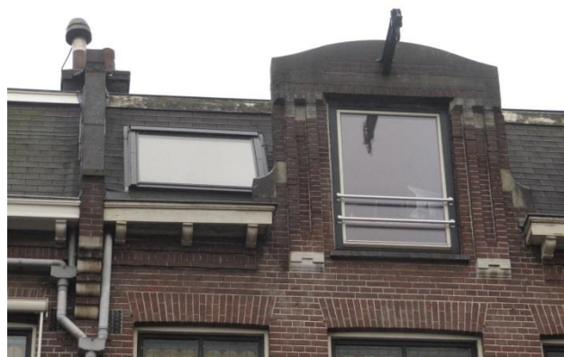
Foto 4: Schuin dakvlak vertoont openingen singels
