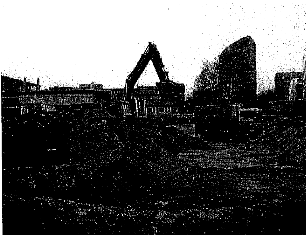
Figuur 1: Ontgraven en in depot plaatsen bovengrond langs Statenlaan
