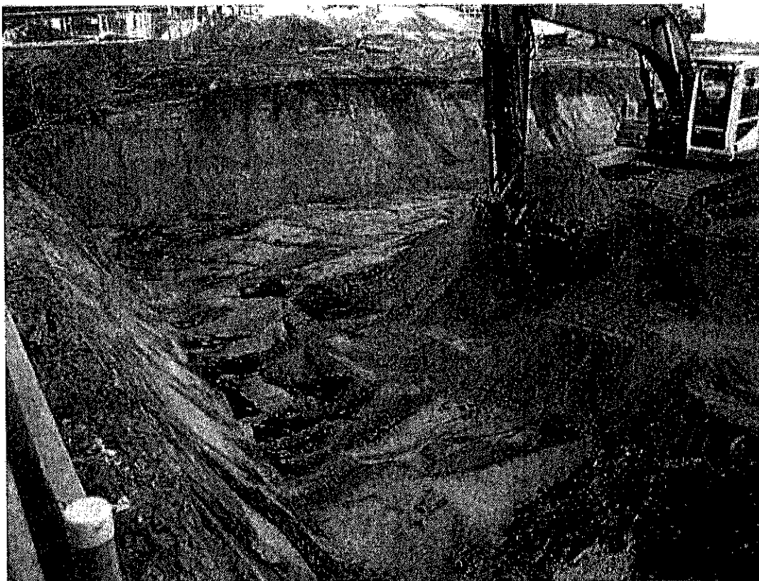
Figuur 5: Grens zandige bovengrond en oud maaiveld tegen locatie E2
