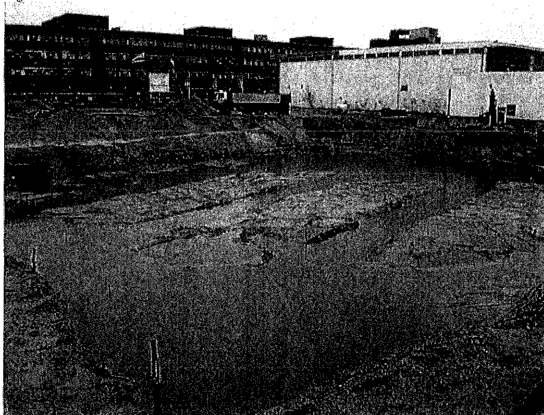
Figuur 12: Einddiepte ontgraving (tot onder grondwaterspiegel)
