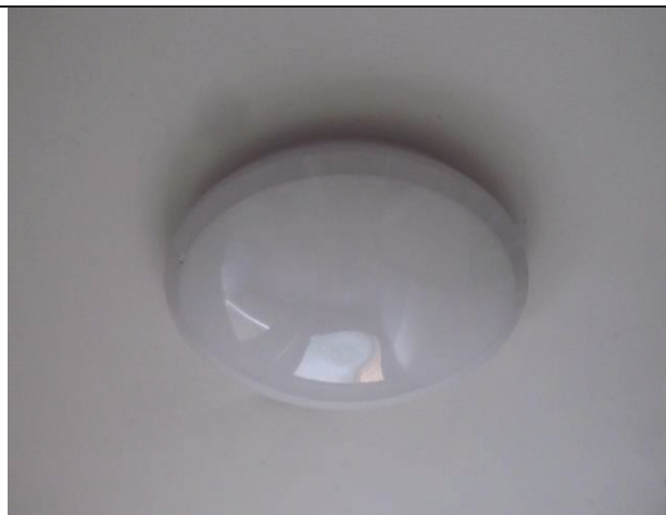
Foto 9. De armaturen zijn vernieuwd.
