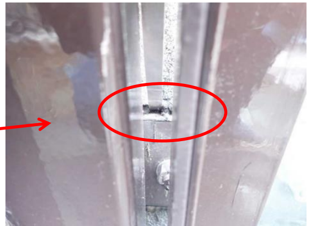
Afb 19. Voorbeeld van één van de openingen in de dakbedekking rondom de montageplaat afscheiding.
