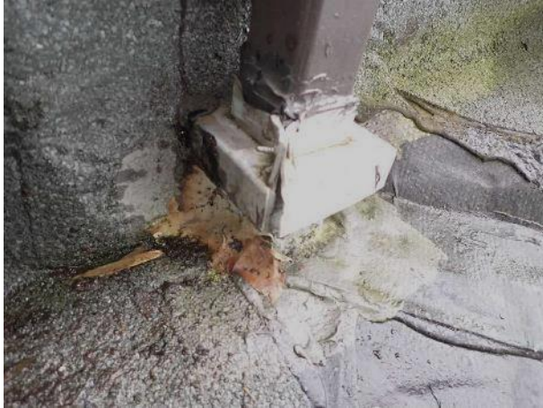
Afb 16. Aanzicht met kit afgedichte aansluiting baluster en dakbedekking.
