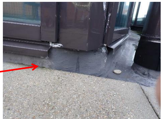
Afb 15. Aanzicht van de craquelé in de coating.
