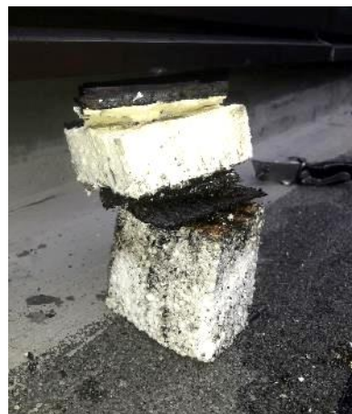
Afb 33. Aanzicht opbouw dak.
