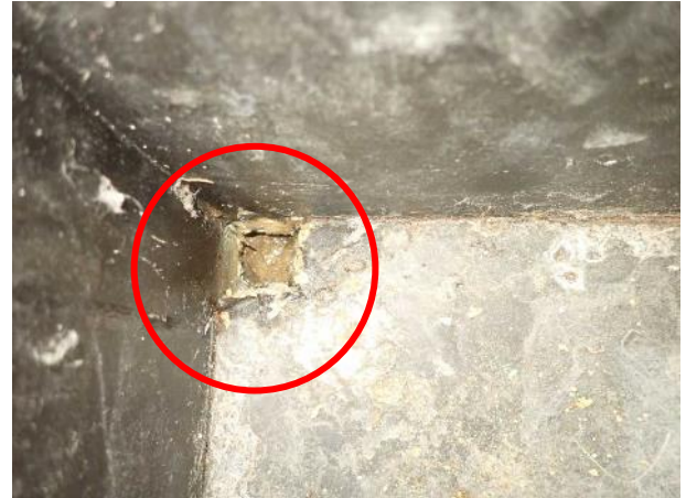
Afb 6. Aanzicht van water op de constructieve vloer in één van de convectorputten.
