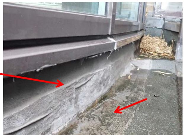
Afb 13. Aanzicht van de craquelé in de coating.
