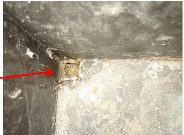
Afb 2. Detailopname van water onder één van de convectorputten.
