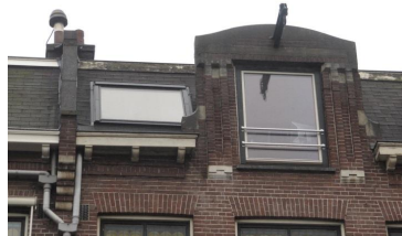
Foto 4: Schuin dakvlak vertoont openingen singels
