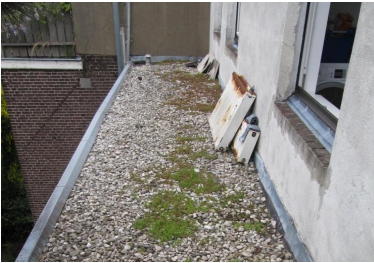
Foto 1: Radiatoren, tegels en groen op dak aanwezen, dit afvoeren
