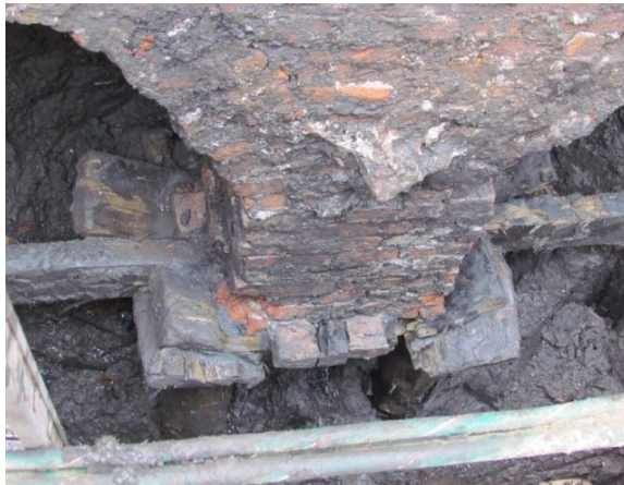
Ingezoomde foto inspectieput van bovenaf
