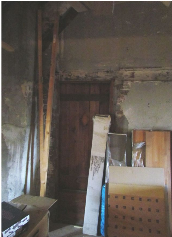
Branddeur zolderverdieping tussen 36 en 38.
