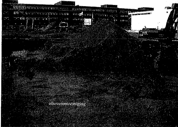
Figuur 4: Outgraving olieverontreiniging
