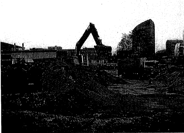
Figuur 1: Ontgraven en in depot plaatsen bovengrond langs Statenlaan
