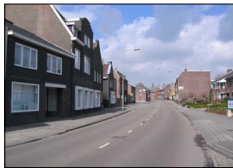
Lintbebouwing langs de Nieuwstraat
