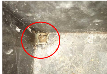
Afb 6. Aanzicht van water op de constructieve vloer in één van de convectieputten.
