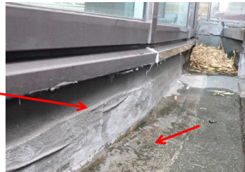
Afb 13. Aanzicht van de craquelé in de coating.
