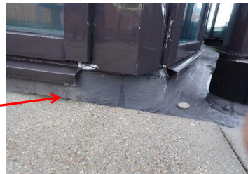
Afb 15. Aanzicht van de craquelé in de coating.
