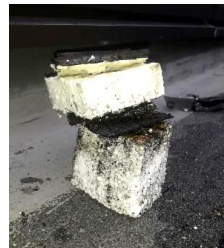
Afb 33. Aanzicht opbouw dak.
