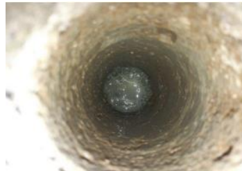
Afb 4. Detailopname van water in de vloer t.p.v. kernboring 1.
