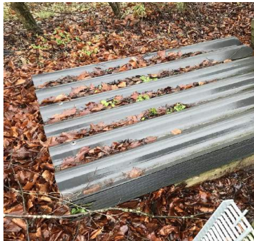
Asbestvrije golfplaten op mestplaat
