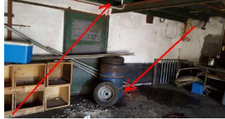
restanten begane grond en in buis
