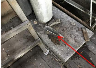
restanten op verdieping
