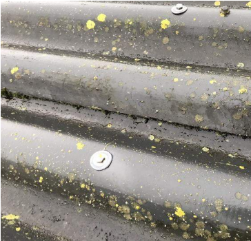
Asbestvrij dak op schuur buiten onderzoeksgebied
