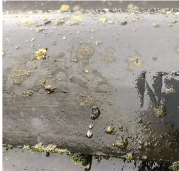
Nt codering dak schuur buiten onderzoeksgebied
