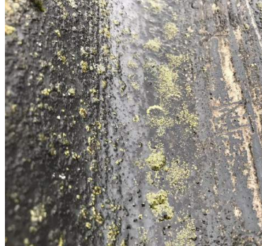
Nt codering golfplaten dak schuur 5
